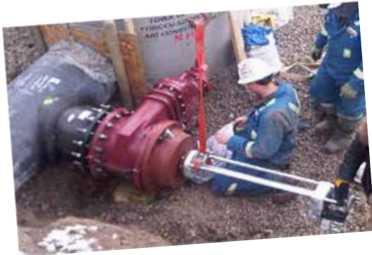
Kanada - 28"x18" IPS EF Seme Canlı Hat Bağlantısı Canada - 28"x18" IPS EF Saddle Hot Tapping Application
