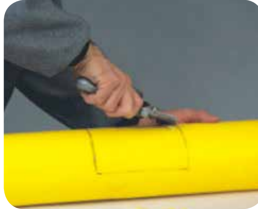
Oksitli tabakanın traşlanması/ Scraping the oxidated layer
